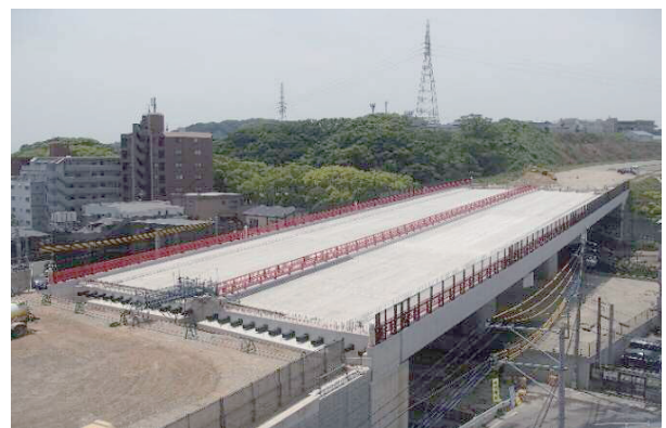
写真-6 完成写真
