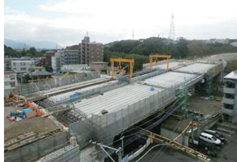
写真-4 主桁架設 (STEP-3)
