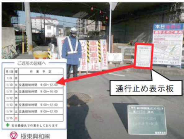
写真-5 交通規制状況
