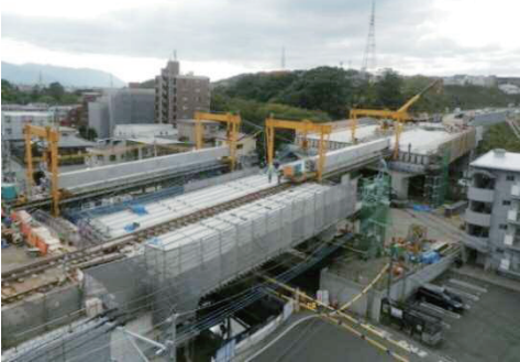
写真-3 主桁架設 (STEP-2)
