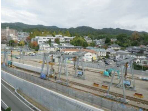
写真-1 主桁仮置きヤード (STEP-1)
