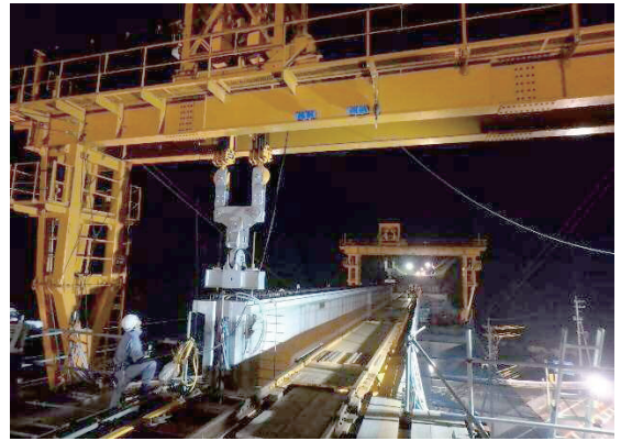
写真-8 主桁架設 (降下)
