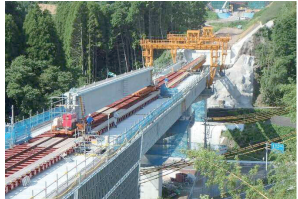
写真-3 主桁引き出し状況
