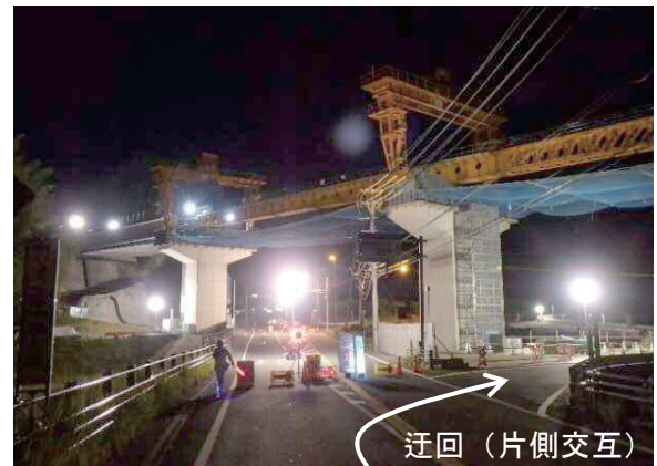
写真-2 交通規制 (主桁架設時)
