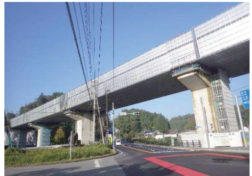
写真-9 吊足場全景
