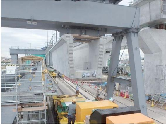
写真-2 隔壁を省略したU形プレキャスト桁
