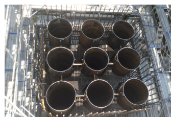
写真-1 施工状況
