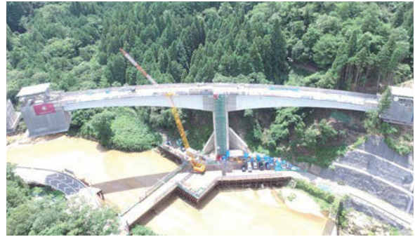
写真-1 施工写真
