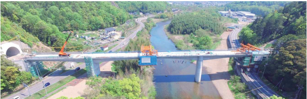
写真-5 ドローンによる航空写真(撮影：平成30年4月)
