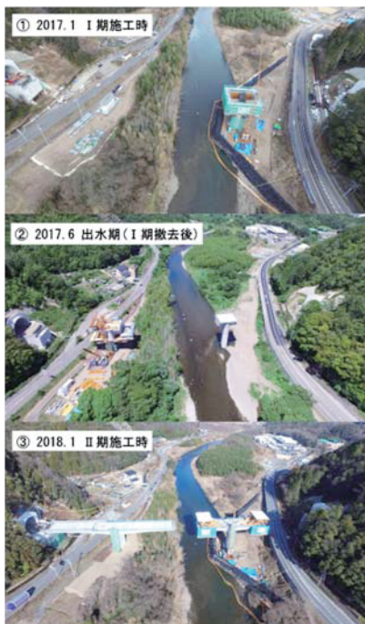
写真-4 P2 橋脚施工状況
