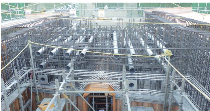
写真-2 偏向管ユニット設置完了状況
