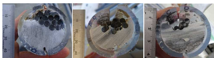
写真-4 切断面（注入口から 5m 離れた位置）
