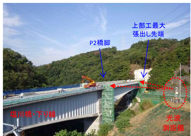
写真-1 下り線 A2 上部工の高さ計測状況
