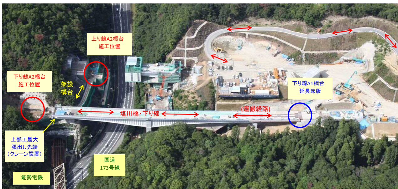
写真-2 下部工施工における掘削土の運搬経路
