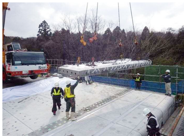
写真-4 プレキャスト延長床版架設状況
