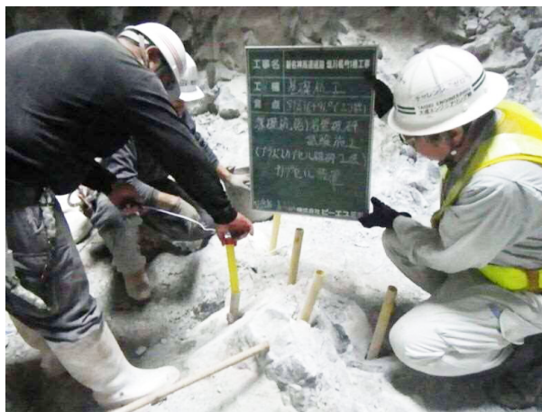
写真-3 低振動破碎工法施工状況
