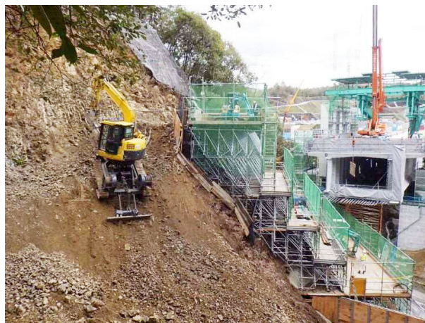
写真-6 クライミングバックホーによる掘削状況
