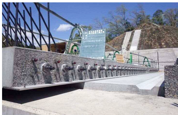
写真-5 NAPP 鋼棒緊張力解放完了状況
