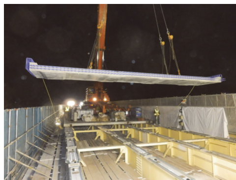
図-1 PC床版の取り替え状況
