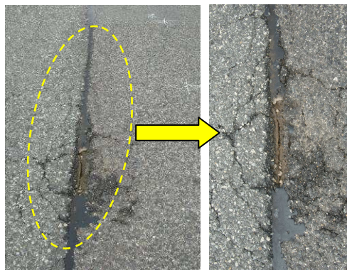
写真—2 舗装施工継目
