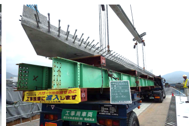
写真－7 PCa床版の運搬
