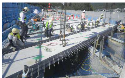
写真－6 PCa床版架設状況
