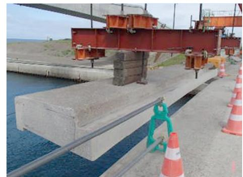
写真-2 張出し床版撤去状況
