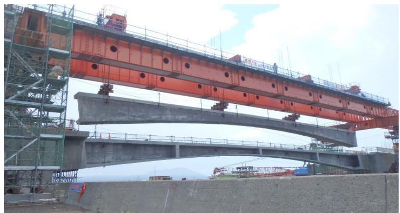
写真-3 主桁吊上げ状況
