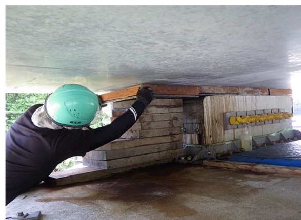
写真-3 押出し状況（滑り支承部）
