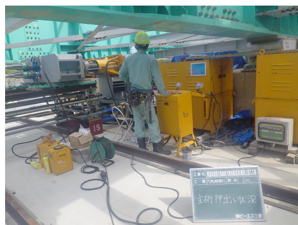
写真-2 押出し状況（押出し装置）
