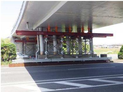
写真-15 支保工補強完了
