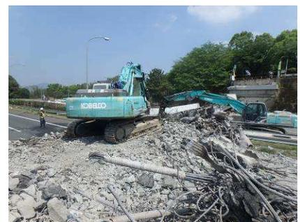
写真-12 PC鋼材の状況
