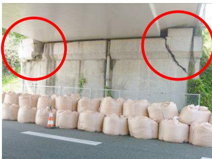
写真-4 A2変位制限構造の破損
