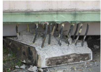
写真-3 変位制限構造の破壊
