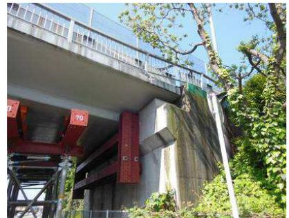
写真-17 仮設の変位制限構造
