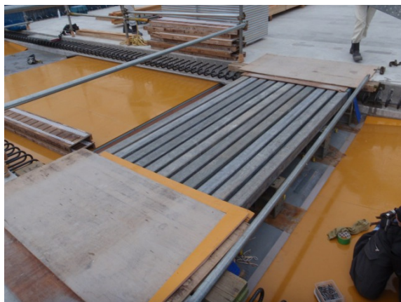
写真-3 場所打ち部通路の設置
