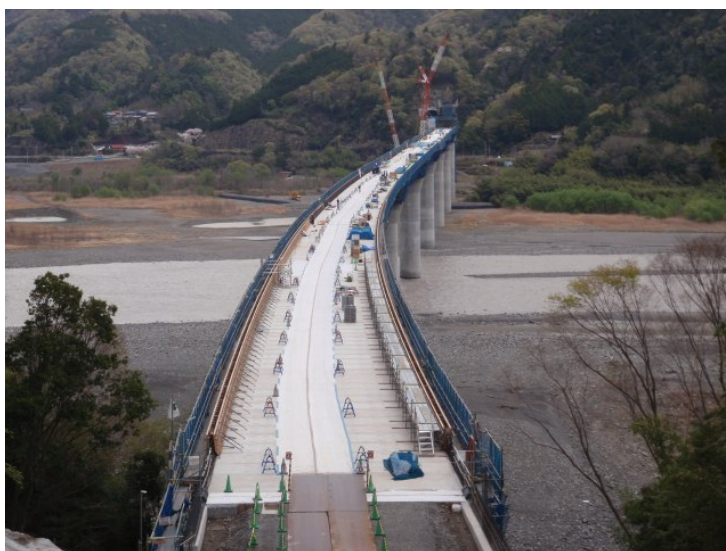
写真－8 全景（床版施工完了）
