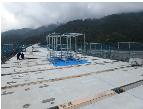
写真-4 間詰め部作業床の確保
