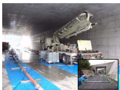
写真－5 配管試験施工
