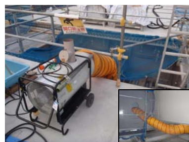
写真－7 桁下給熱養生
