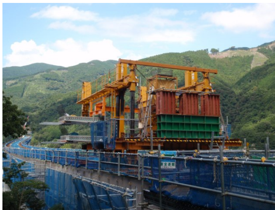
写真-2 PC床版架設状況
