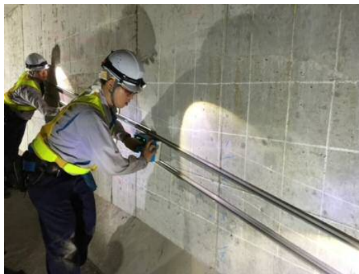
写真-3 調査状況 (A橋ウェブ部)
