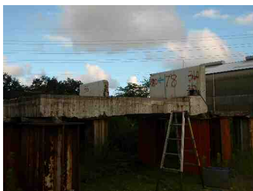
写真-1 試験対象床版全景
