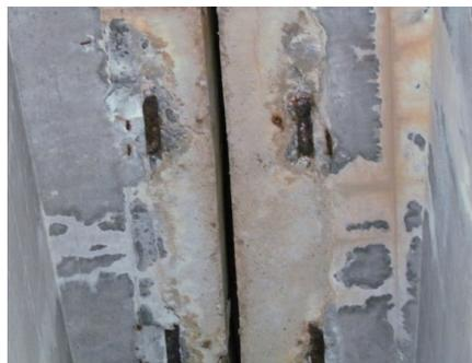
写真-2 床版横締め定着体の露出および腐食 (ポストテンションT桁橋)
