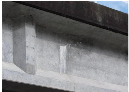
写真-4 主桁シースに沿ったひび割れ (ウエブ)
