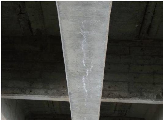
写真-3 主桁シースに沿ったひび割れ (下フランジ)
