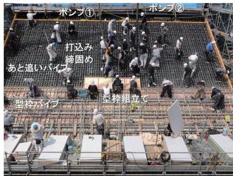
写真-7 斜材コンクリートの施工状況
