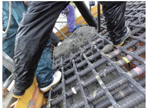
写真-1 金網部の打込み状況
