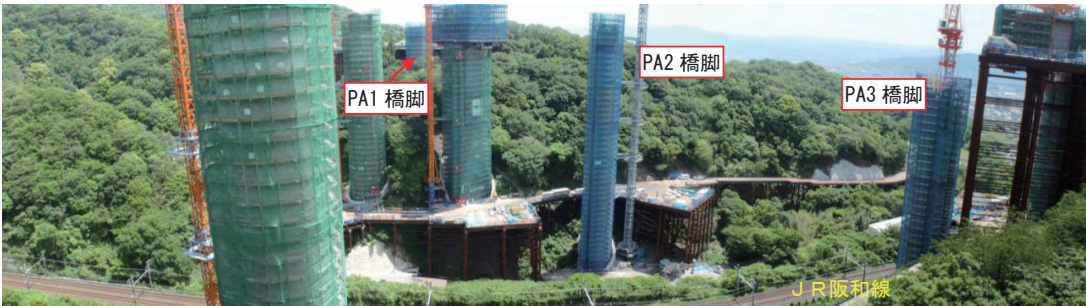
写真－1 PA1～PA3付近施工状況
