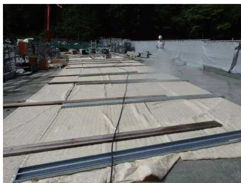
写真－3 床版養生状況
