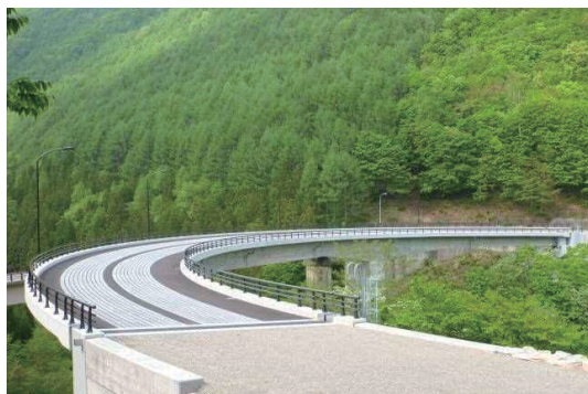
写真－4 起点側より
