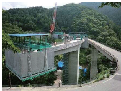
写真-1 張出し施工状況
