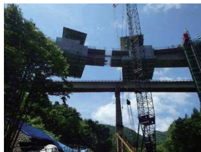
写真-2 中央閉合工施工前
