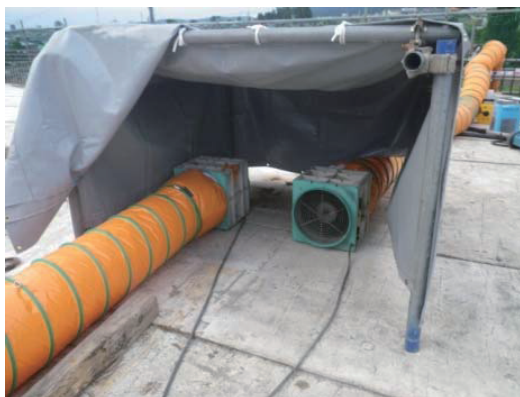
写真-3 パイプクーリング(送気状況)
