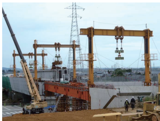
写真-2 PD30～A2 径間架設状況
