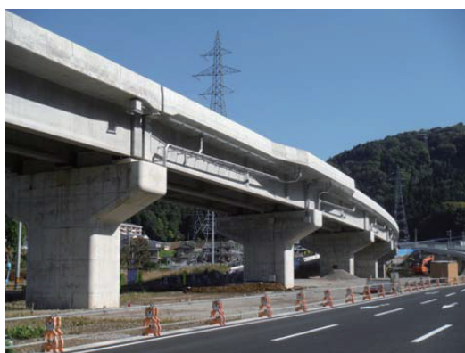
写真-5 施工完了(側面より)
