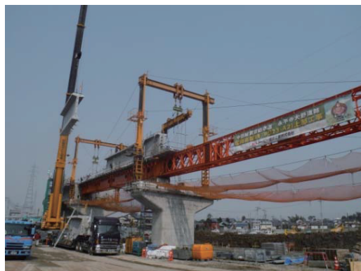
写真-1 PD23～PD29 径間架設状況
