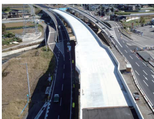
写真-6 施工完了(橋面より)
