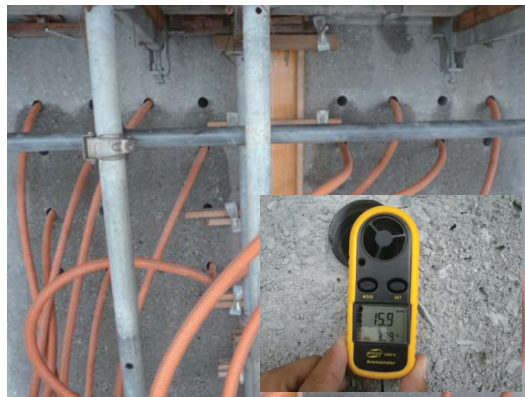
写真-4 パイプクーリング(風速計測状況)
