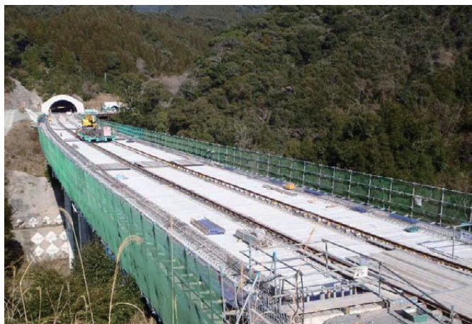
写真－11 現場全景（架設完了時）
