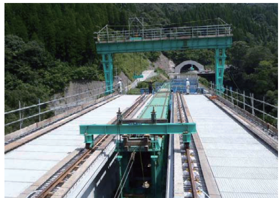
写真－6 専用吊金具による架設桁の吊り下げ移動
