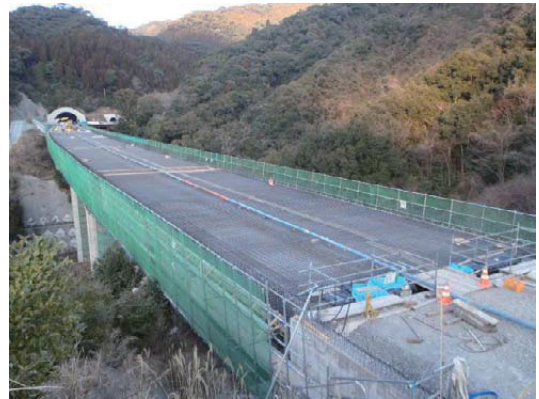
写真－4 水平配管によるポンプ打設
