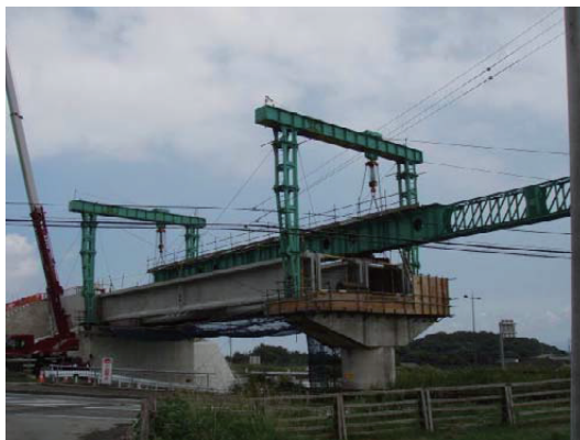
写真－5 一般的な架設桁移動
