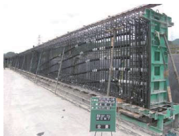
写真－8 PEシース設置
