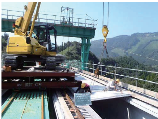
写真-2 G1~G2 桁間のPC板先行設置
