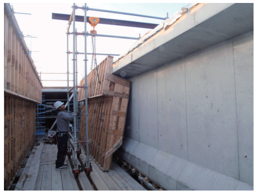
b) 型枠設置状況
