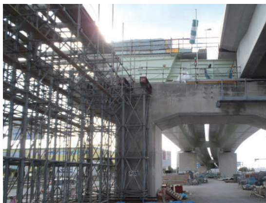
写真-3 横取り架台設置状況
