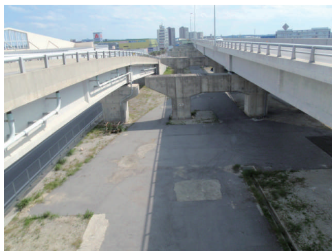
写真-1 施工前 (P29 から)
