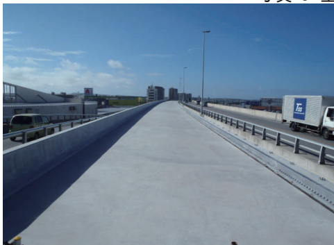
写真-6 施工完了(P29 から)
