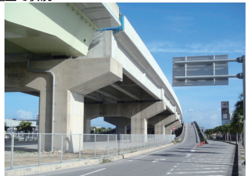
写真-7 施工完了(P35 から)
