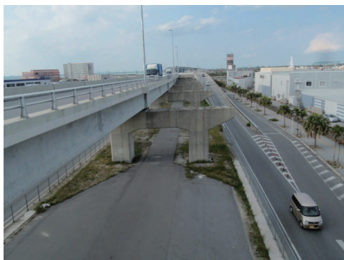
写真-2 施工前 (P35 から)
