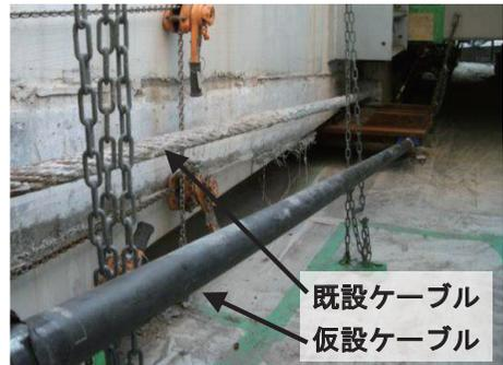
図-6 既設ケーブルと仮設ケーブルの配置状況
