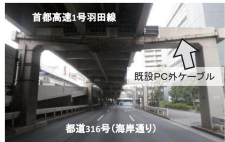
写真-1 PC 外ケーブルの設置状況
