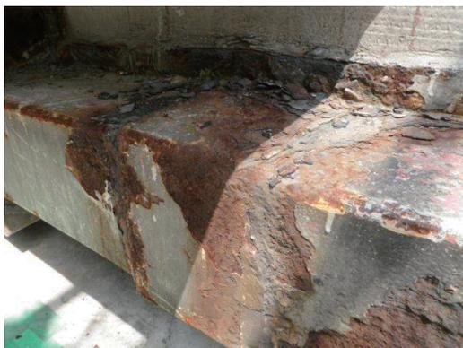
写真-2 腐食したケーブルカバー
