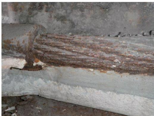
写真-3 グラウト未充填箇所でのケーブルの発錆
