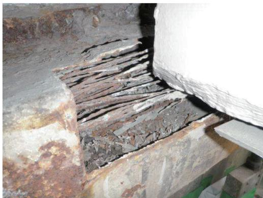
写真-5 主桁干渉部カバー切欠きでのケーブル破断
