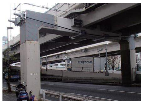
写真-9 新設外ケーブルの設置状況
