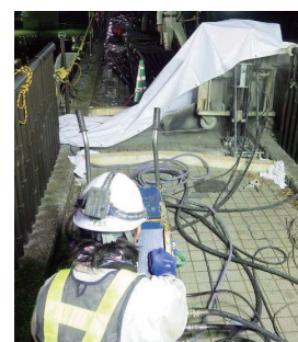
写真-3 PC 桁切断状況
