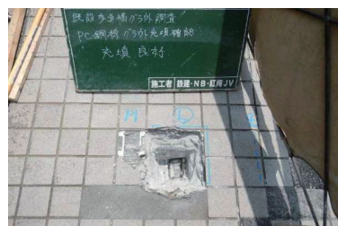
写真-1 グラウト充填確認
