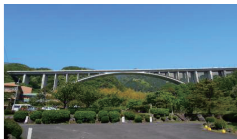
写真－6 耐震補強後の別府明礬橋
