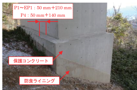
写真－2 建設時の橋脚の温泉腐食対策
