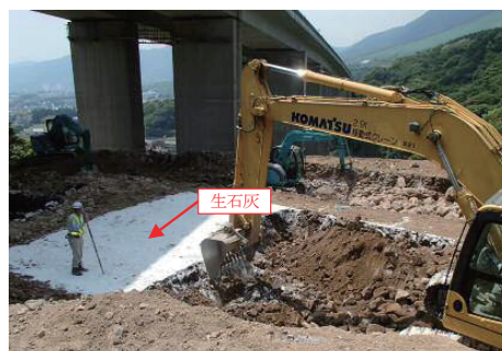
写真－4 埋戻し土への石灰混合
