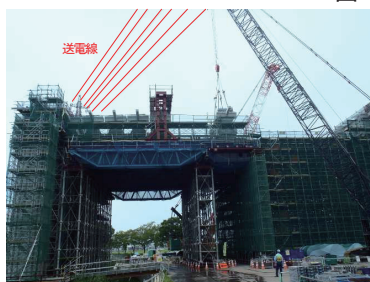
写真-5 セグメント上架・門構架設
