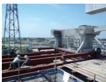
写真-3 柱頭部セグメント縦移動
