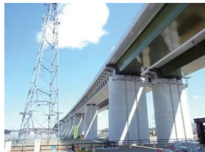
写真-1 桶川第4高架橋全景
