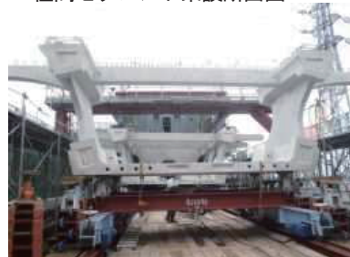
写真-6 セグメント 重量台車 縦移動
