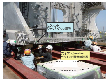
写真-4 柱頭部セグメントジャッキダウン
