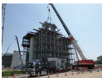
写真-2 柱頭部セグメント上架
