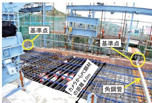
写真-5 計測写真の例 (張出し施工)
