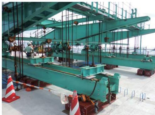
写真-4 鉛直方向拘束材設置状況
