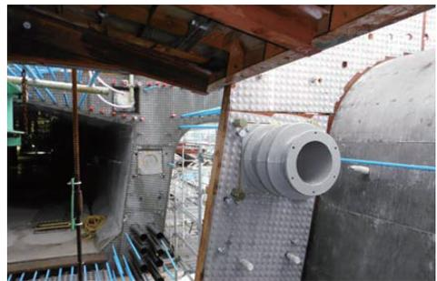
写真-1 補強用PC定着具配置状況
