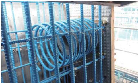
写真-2 PC定着具補強筋配置状況
