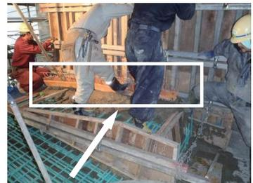
写真-5 マルチバイブレーターの使用、挿入位置マーキング、コン止めくしの使用
