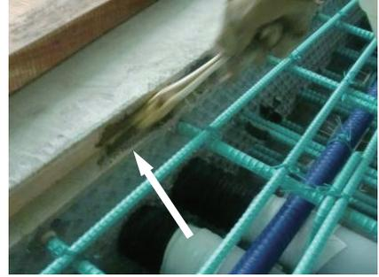
写真-3 段差構造と接着剤塗布
