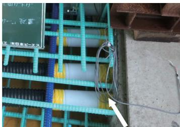
写真-7 MSセンサー設置、広帯域超音波法実施状況
