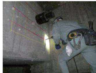
写真-4 削孔法
