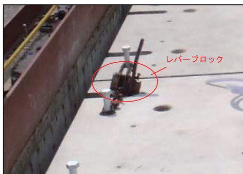
写真-2 レバーブロックによる固定
