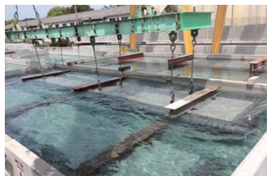
写真-4 灌水養生状況
