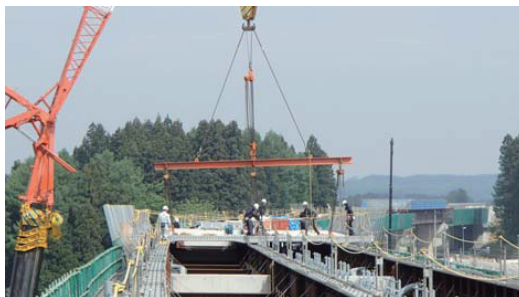
写真-3 PC床版架設状況
