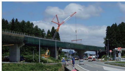
写真-2 PC床版架設（国道より撮影）
