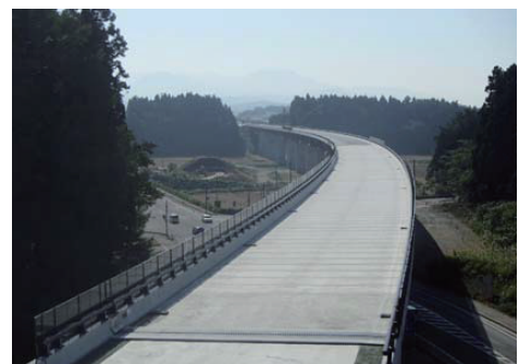
写真-1 完成写真（終点側より）
