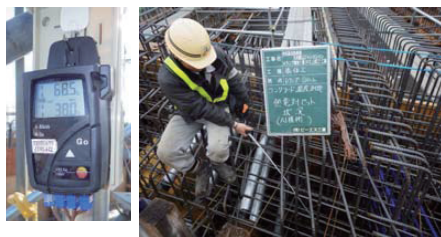
写真－3 端支点横桁部温度計測状況
