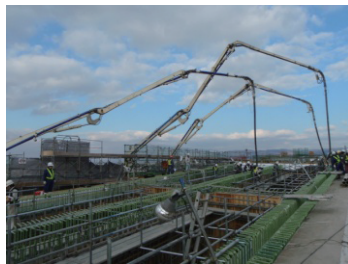
写真－2 コンクリート打設状況
