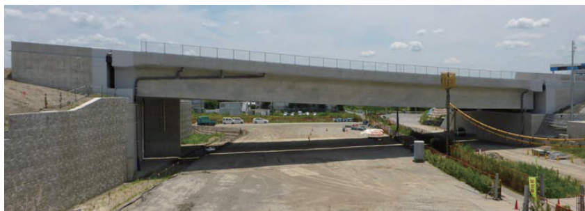
写真－5 施工完了全景(平成 26 年 7 月撮影)
