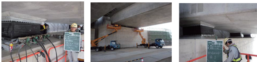
写真－4 ポストスライド施工状況
