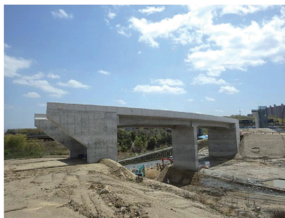
写真－1 橋体完成状況
