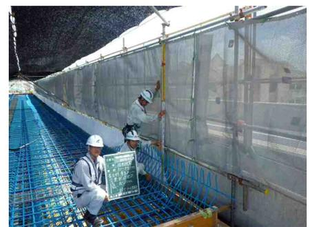
写真-5 飛散防止柵設置
