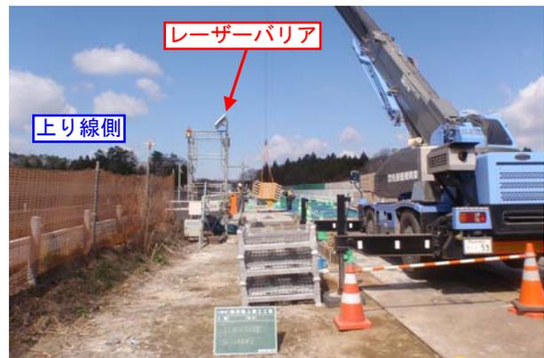
写真-6 レーザーバリア設置状況
