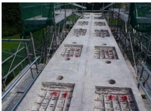
写真-1 下部工はつり完了状況
