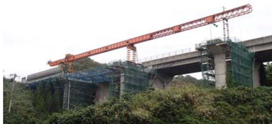
写真-3 架設桁設置状況
