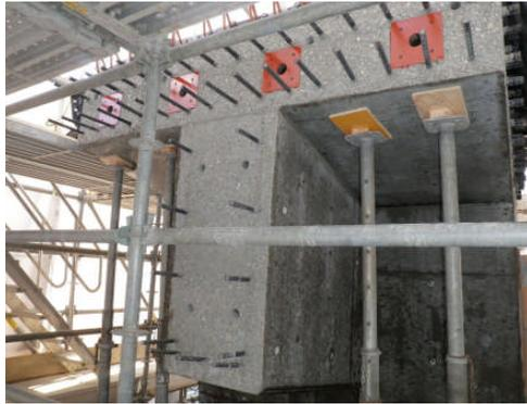
写真-7 脱枠後のリブ部外観
