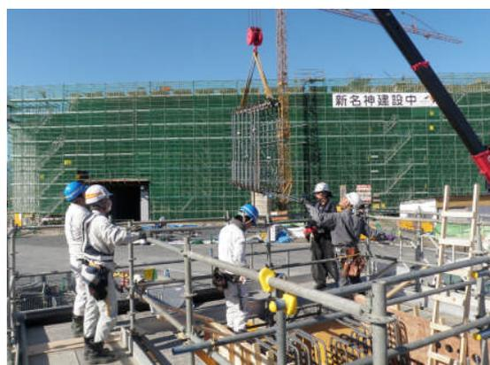
写真-5 リブ部プレファブ鉄筋の架設
