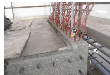
写真-8 張出床版劣化防止対策完了
