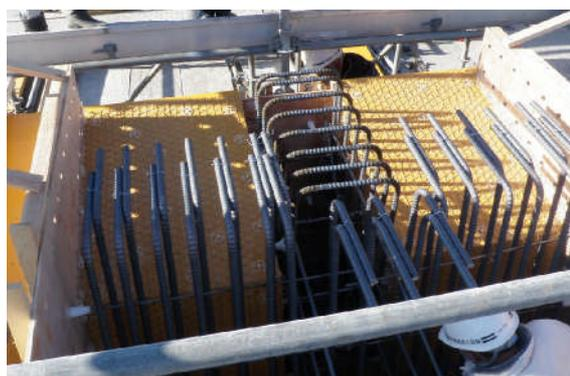
写真-6 リブ鉄筋設置完了
