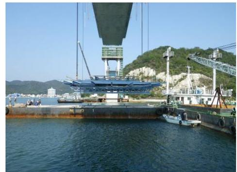
写真-4 移動作業車床吊下ろし
