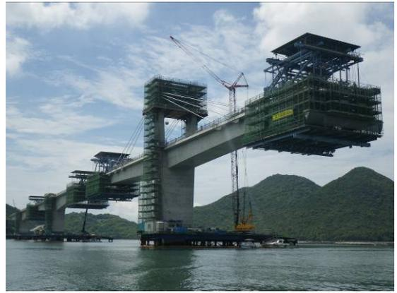
写真-3 超大型移動作業車
