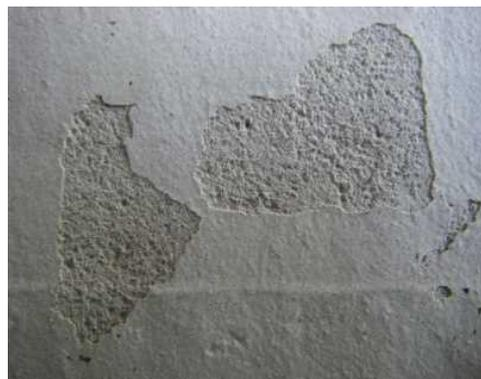
写真-1 硬化後の仕上げ面の剥がれ
