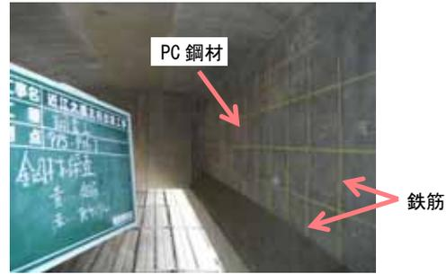
写真-2 PC ケーブル・鉄筋位置の特定
