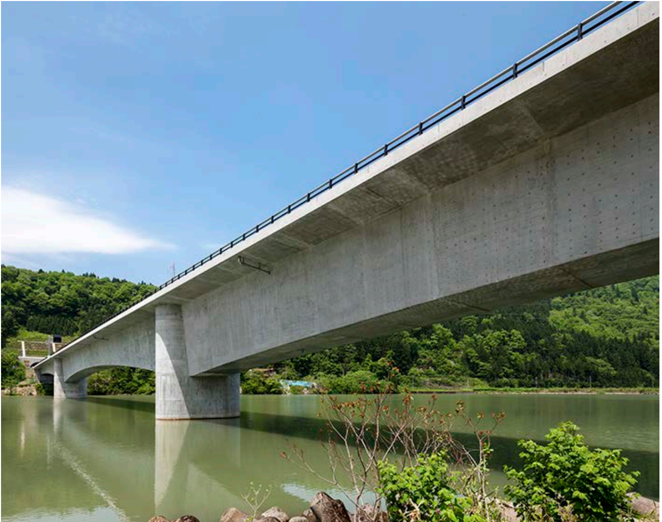
写真-3 斜ウェブの陰影効果と排水管設置状況
