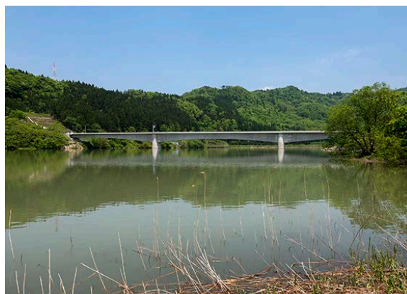
写真-2 下流から見た小花地大橋の全景
