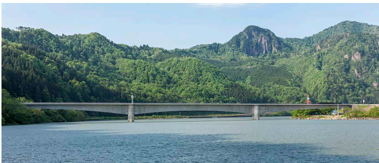
写真-1 揚川ダムから見た小花地大橋の全景
