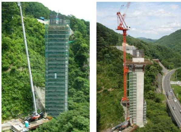
(a) 移動式クレーン据付け状況 (b) タワークレーン組立て後 (脚頭部施工時) (柱頭部施工時)
