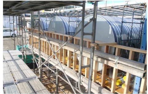
写真-1 型枠組立完了
