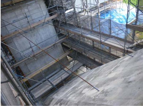
写真-1 斜材・垂直材連結 PC 鋼棒配置状況
