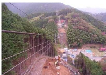
写真-1 ケーブルクレーン稼動状況 (下部工)
