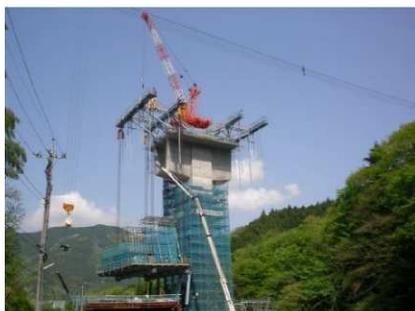
写真-3 大型移動作業車組立状況
