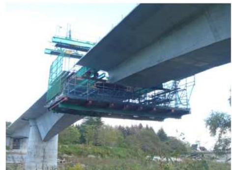
写真-9 吊支保工設置完了
