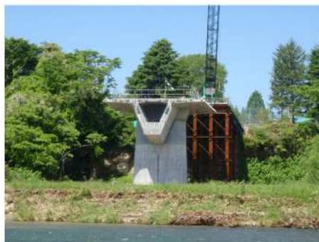
写真-6 仮栈橋設置状況(柱頭部施工時)
