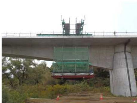
写真-7 下段作業台吊上げ状況
