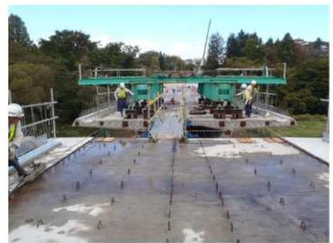
写真-8 吊支保工移動状況
