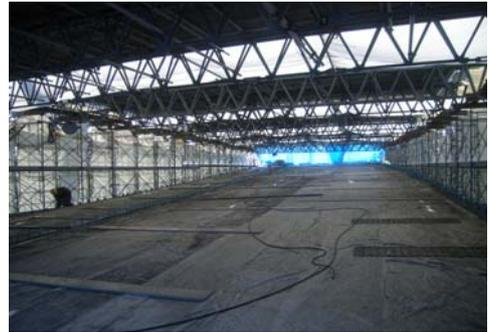
写真-2 全天候型養生屋根設備
