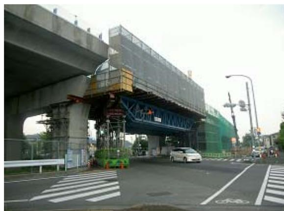
写真－3 トラスを使用した支保工
