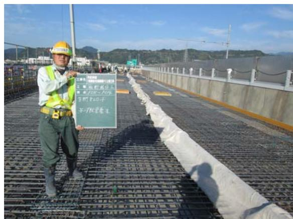
写真-7 配管の保護・散水
