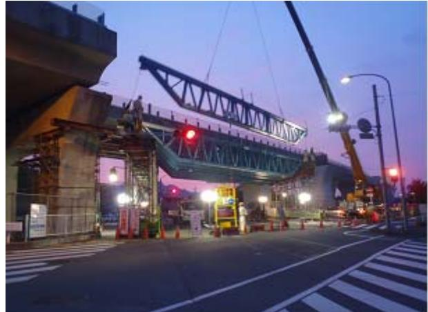
写真-5 大型クレーンによる夜間架設状況
