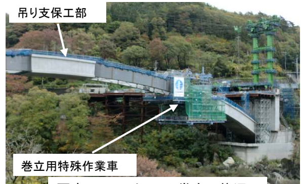
写真-3 コンクリート巻立て状況
