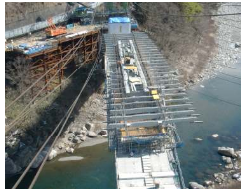
写真-5 水平リブ設置状況(鉄塔上から)
